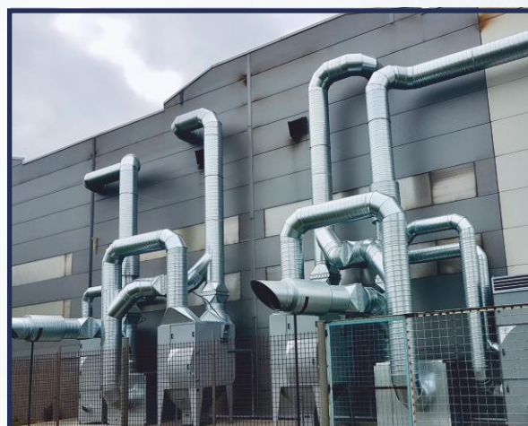
Zespół filtracyjny GM9V XL z wentylatorem o mocy 22kW w obudowie dźwiękochłonnej oraz zespołem podmieszania powietrza ZPP 5700
