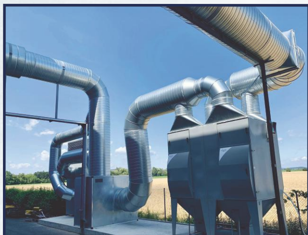
Zespół filtracyjny GM18V XXL z wentylatorem o mocy 55kW w obudowie dźwiękochłonnej oraz zespołem nawiewnym ZPP12800
