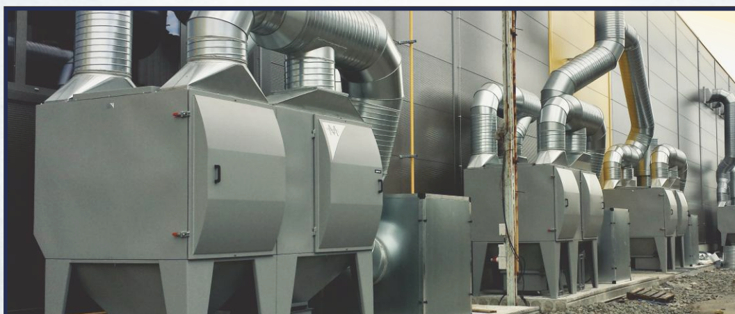
Zespół filtracyjny GM24V XXL z wentylatorem o mocy 90kW w obudowie dźwiękochłonnej oraz zespołem nawiewnym ZPP18000
