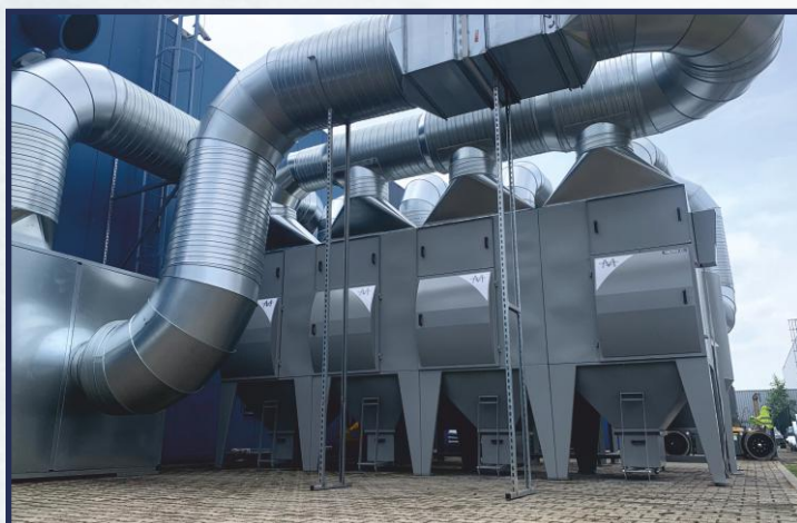
Zespół filtracyjny GM36V XL z wentylatorem o mocy 75kW w obudowie dźwiękochłonnej oraz separatorami rurowym SR1400
