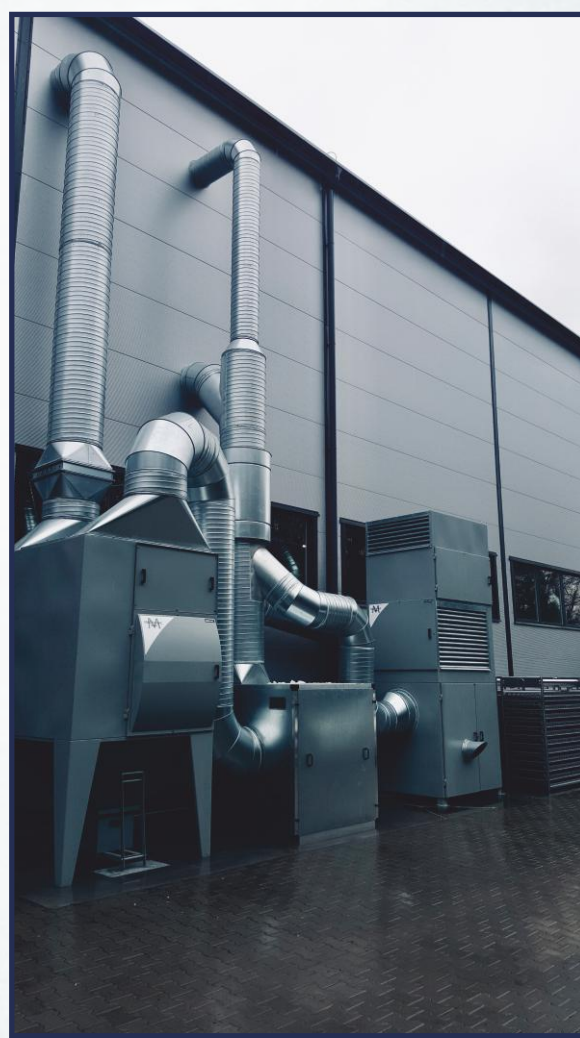
Zespół filtracyjny GM9V XL z wentylatorem o mocy 22kW w obudowie dźwiękochłonnej oraz zespołem nawiewnym ZPP12000
